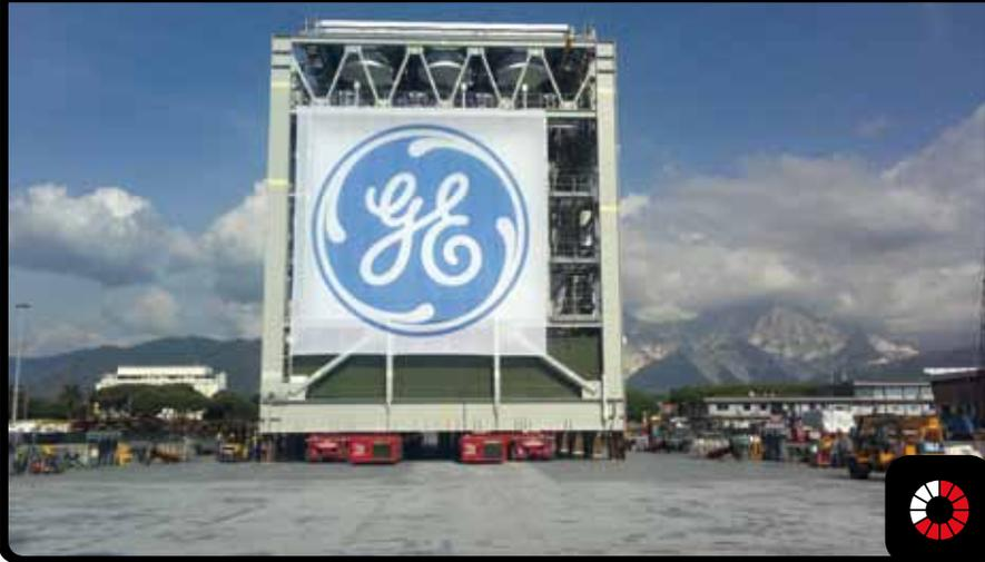
Il primo modulo, denominato GTG1, venne trasportato durante la notte tra il 3 ed il 4 ottobre 2012, impiegando sei ore dal cantiere all'area di parcheggio di fronte all'entrata del porto. Per un'aggiunta di complessità, la geometria del modulo aveva richiesto che esso dovesse essere alzato di 3 metri sul piano dei carrelli SPMT appoggiandolo su speciali blocchi di legno per garantire un maggiore spazio laterale.
